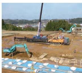
新病院建設工事を開始
